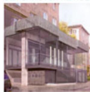
Облицовка козырька и стены будут выполнены из керамогранита с глубоким серо-зеленым цветом и шлифованной поверхностью,
